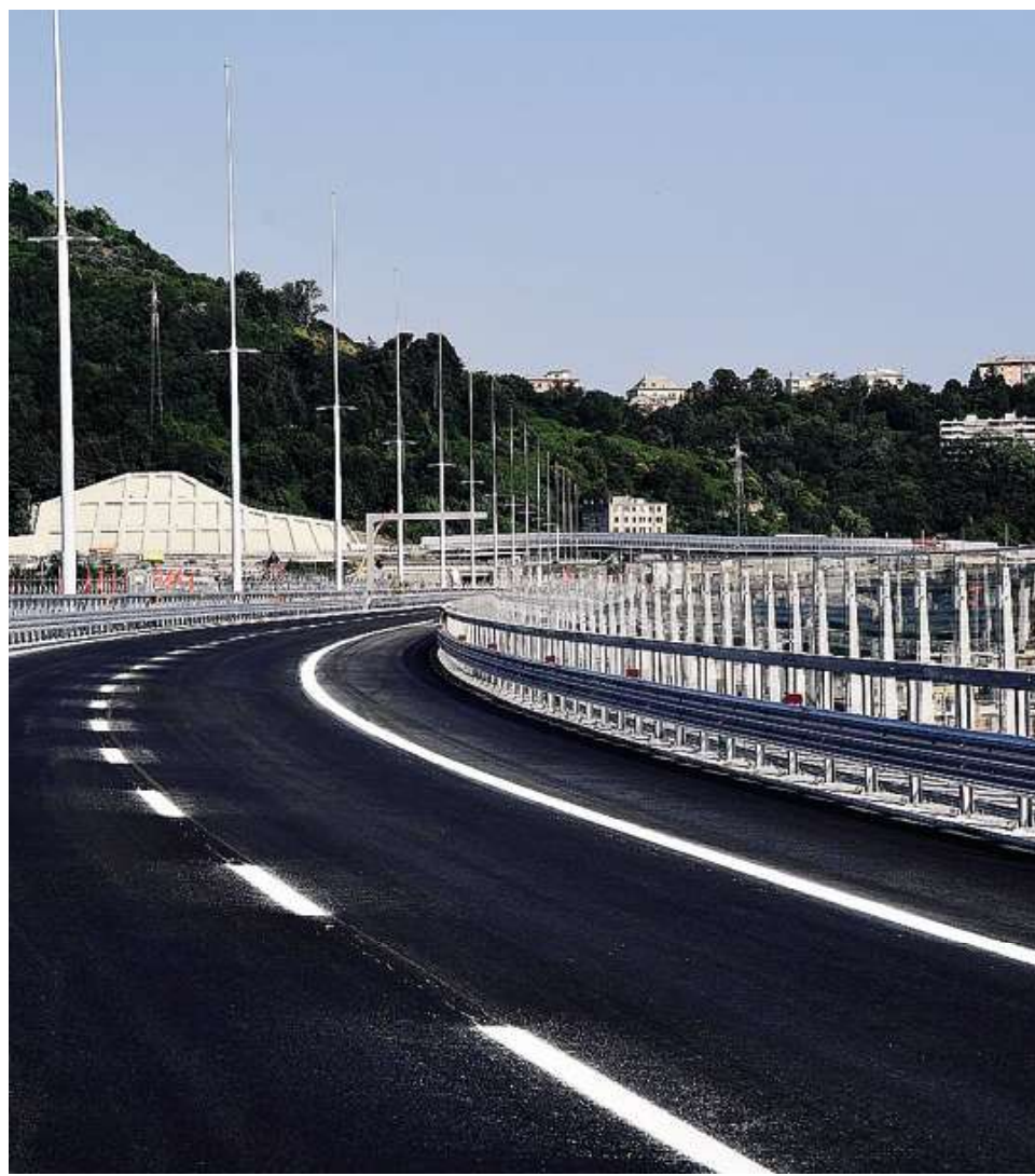
Il nuovissimo asfalto steso sul ponte San Giorgio di Genova, l'ex Morandi, inaugurato ieri
