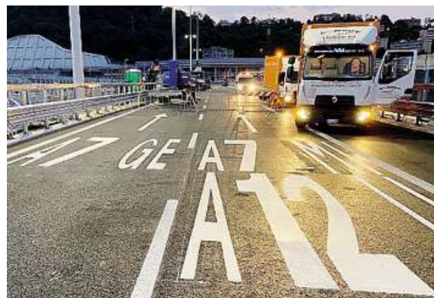
La segnaletica orizzontale realizzata dalla ditta di Valmorea
